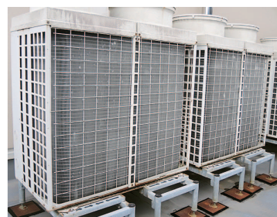
3階に設置されている空調設備の 室外機
